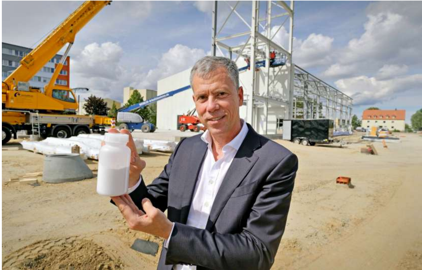
Geschäftsführer Oliver Kolbe auf der Baustelle der beachemie GmbH: In Bitterfeld sollen pro Jahr 25.000 Tonnen feines Salz produziert werden. FOTOS: ANDRÉ KEHRER
